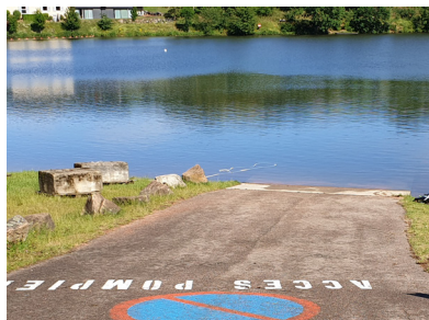
Mise à l'eau, côté digue.
