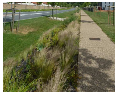
Photographie 7 : Aménagement végétalisé permettant la filtration des eaux pluviales (Source : Graie)
