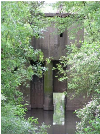
Vanne aval, 9 mai 2008
