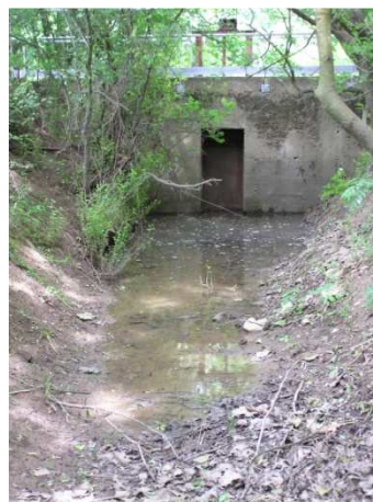
Vanne aval, 1 juin 2006
