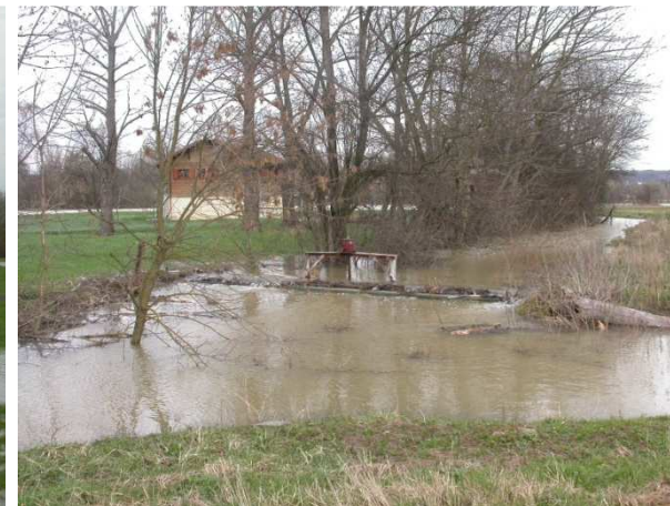
Vanne aval submergée, 6 mars 2007
