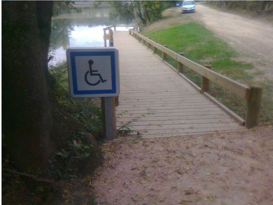
Vue de l'entrée de la rampe
