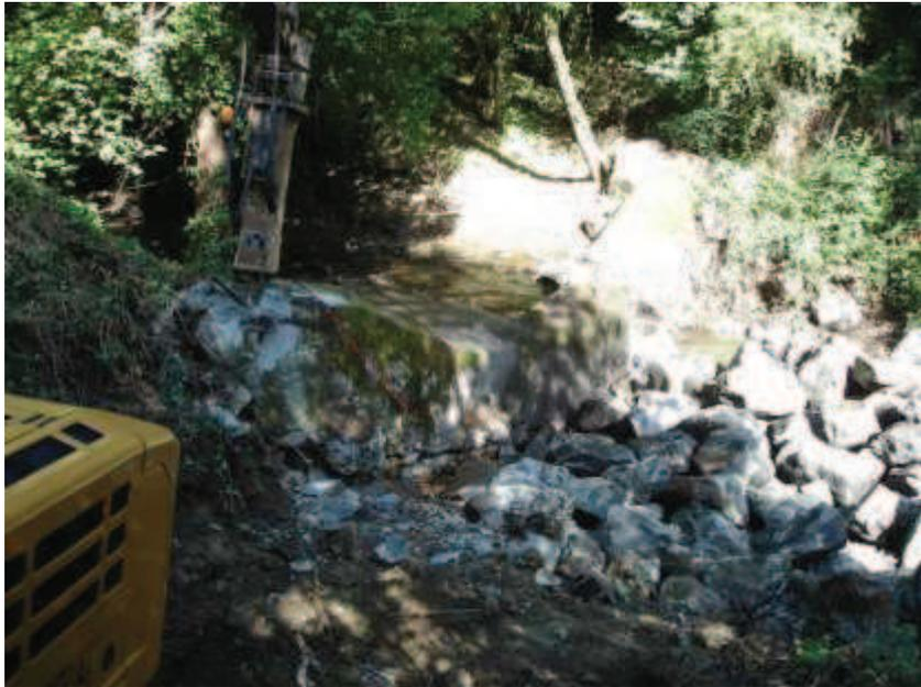
Confection d'une plate forme de travail pour la pelle mécanique à l'aide des blocs présents en pied d'ouvrage
