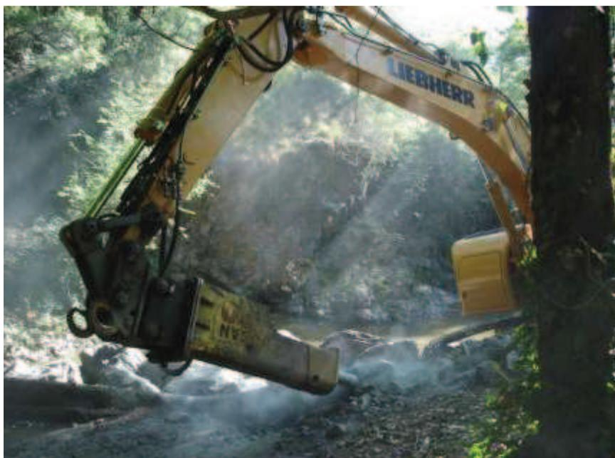
Destruction progressive de l'ouvrage avec le BRH. La nature du béton (béton au laitier) réalisé avec des résidus de fonderie et le ferrailage massif et dense ralentissent considérablement le chantier
