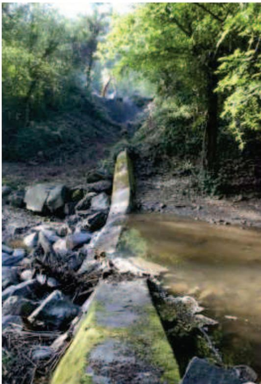
Stade avancé de dégradation, l'ensemble du parement rive droite est déstabilisé, une brèche légèrement désaxée rive gauche se dessine.
