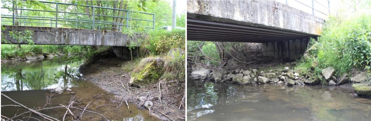
Figure 29: Piles du pont situé dans le remous hydraulique du seuil de Rivat (23/05/2014)
