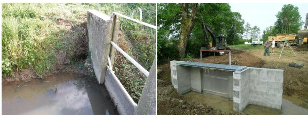
Figure 24: Exemples d'ouvrages installés pour réguler les hauteurs d'eau sur les frayères (Source : FD01)
