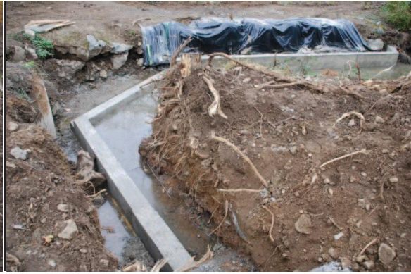
Confection d'un ouvrage de répartition des débits (Rivière de contournement/Bief/sur-verse)
