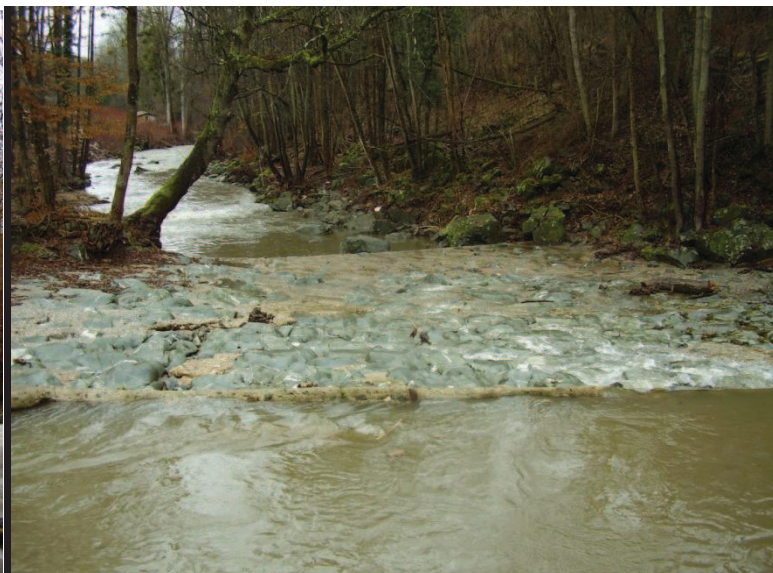
Vue amont de l'ouvrage après son contournement par la crue de Novembre 2008
