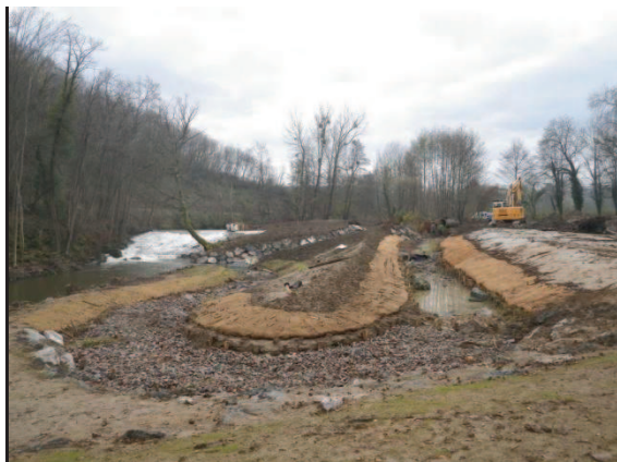
Confection de la rivière de contournement et installation du substrat de fond
