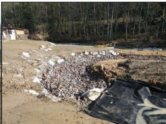
Confection de la rivière de contournement et installation du substrat de fond
