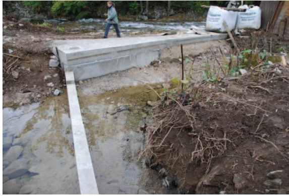
Reprise de la crête du seuil existant et confection d'un ouvrage de calage des débits entrants
