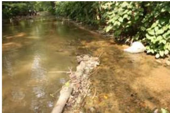
Figure 7: Diversification des vitesses et décolmatage des substrats liés à l'épi (12/09/2012)
