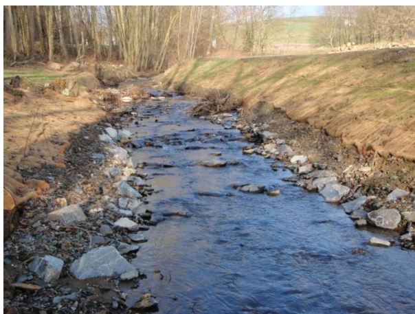
Site amont, rampe en bloc au premier plan
