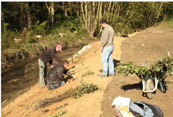
Ancrage de souches dans le lit
