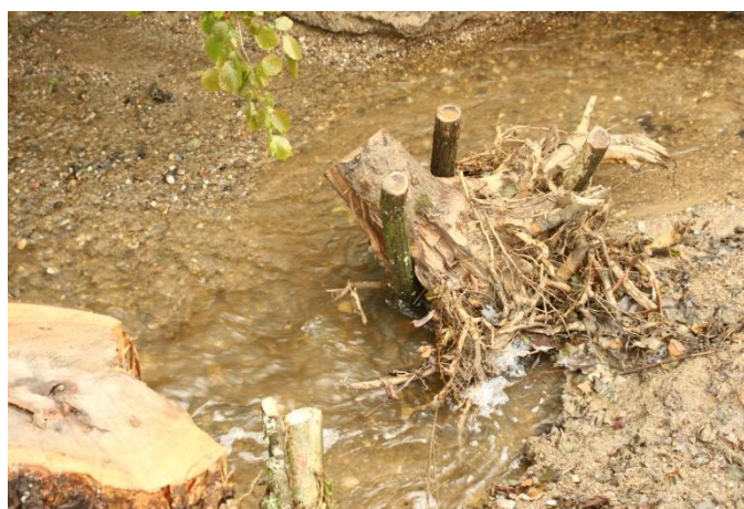
Ancrage de souches dans le lit
