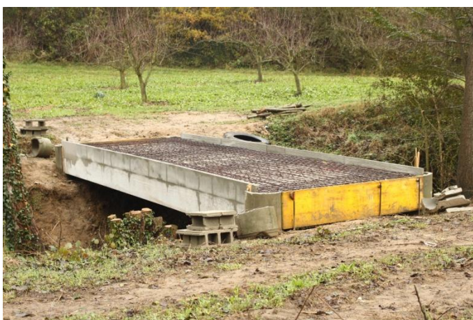
Confection d'une passerelle pour engins agricoles
