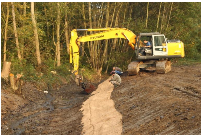
Confection d'une passerelle pour engins agricoles
