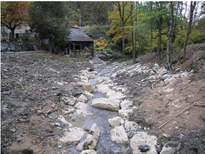
*Rampe en enrochement en aval des dalots, avec blocs déflecteurs et concentration de la veine d'eau en étiage - 02/11/2011*
