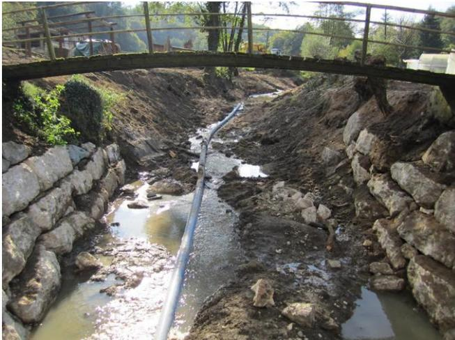
*Enrochement des berges en amont des dalots et sous l'ancienne passerelle - 14/10/2011*
