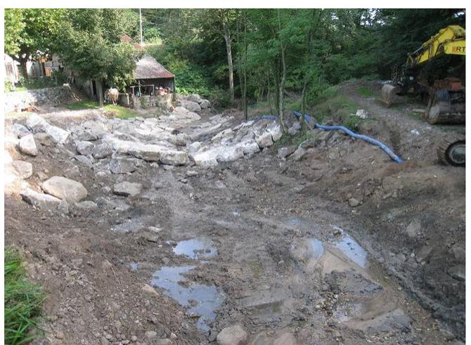
**Mise en place des blocs par l'entreprise Rampa TP, sous forme de rampe rustique à 4% (contrôle extérieur régulier de la topographie de l'ouvrage) - 15/09/2011**
