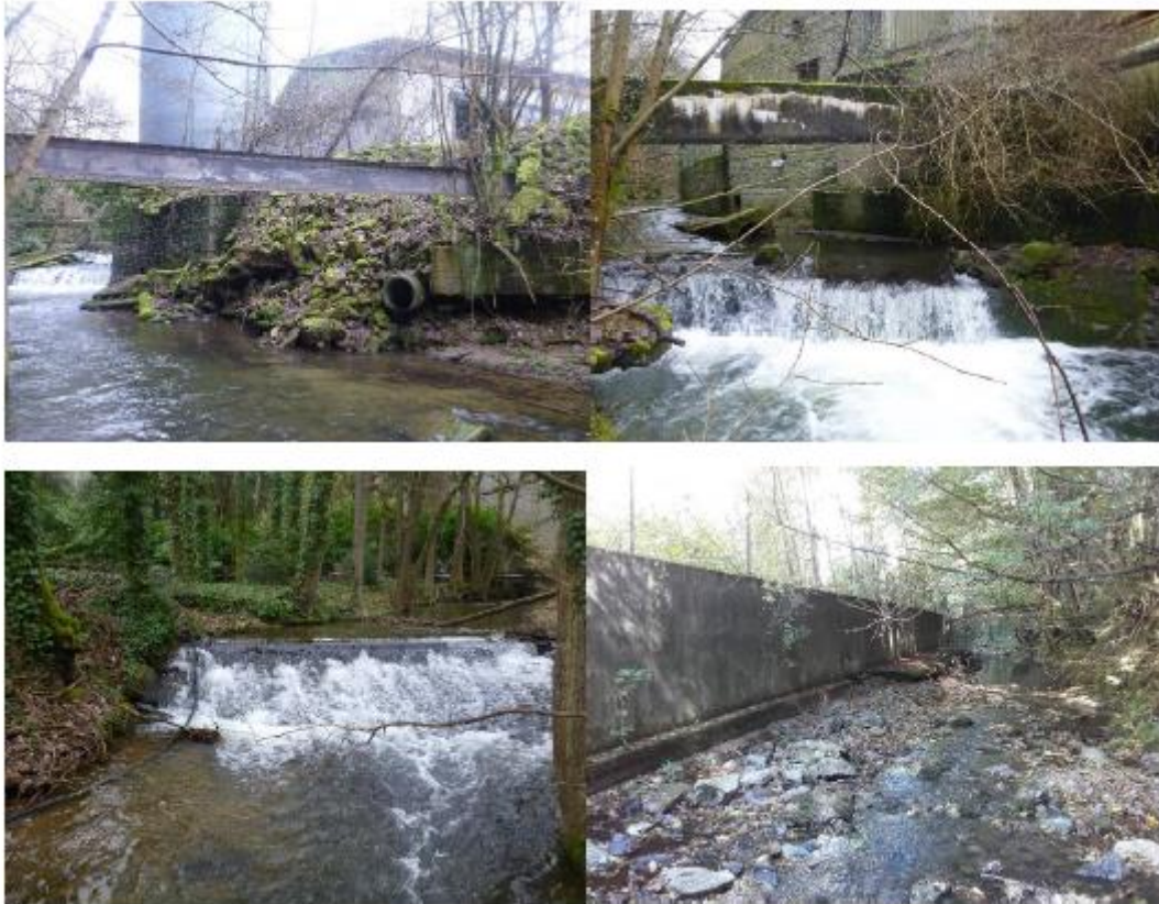
Figure 4: Illustration de différentes portions du sirtre perturbées par la présence d'aménagements en berges ou en travers du lit du cours d'eau - SYRIBT 2017
