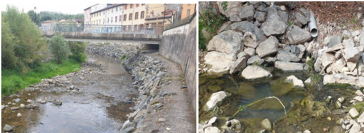
Figure 16: Protections de berge et déversoir d'orage (14/09/2021)
