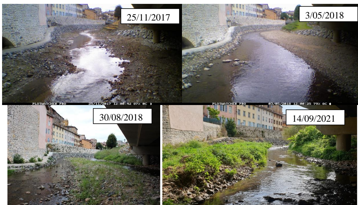
Figure 14: Evolution du lit au niveau de l'ancien seuil
