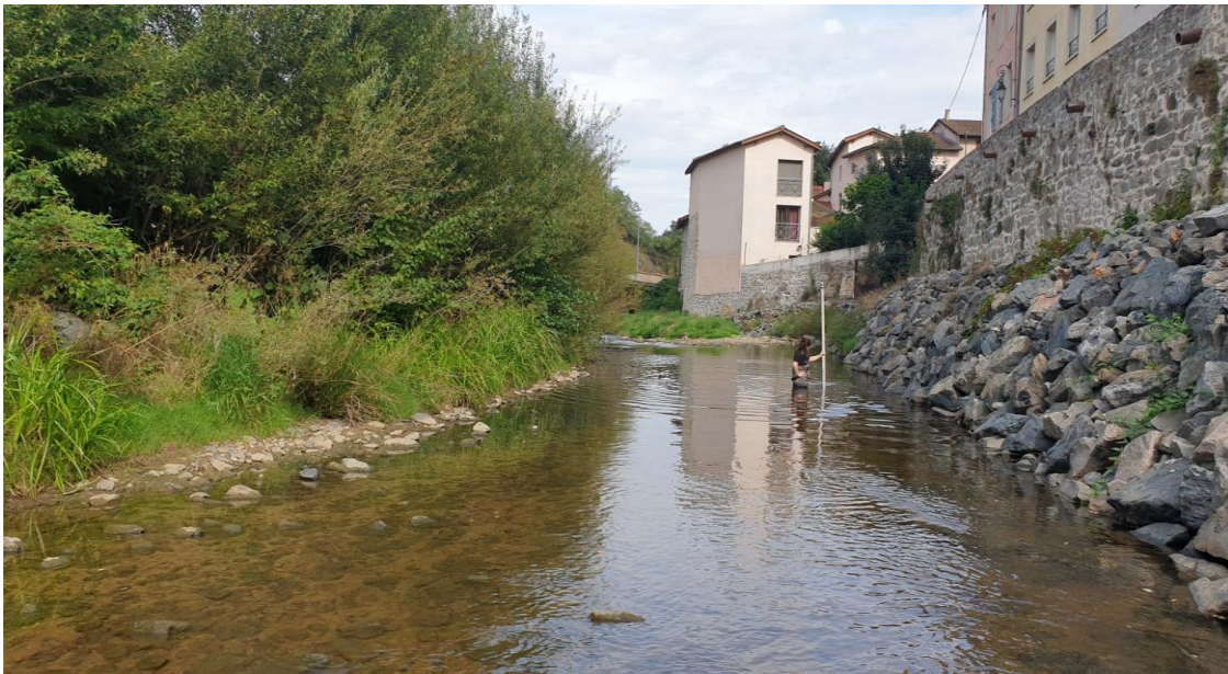
Figure 29 : Photo d'enrochements plantés (à gauche) et non plantés (à droite) sur la Turdine à l'Arbresle (Gacon, 2021)
