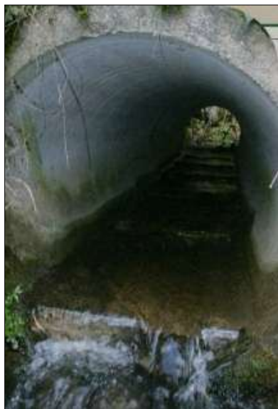
Photographie 32 : Implantation de petits seuils dans une buse (Sources : LIFE 04NAT/FR/000082)
