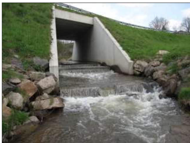
Photographie 31 : Aménagement de bassins successifs réalisé en Saône-et-Loire sur la Toule (bassin de la Grosne) à Trambly
