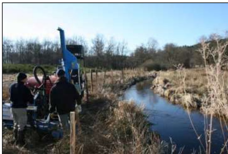
Photographie 29 : plantation d'un clôture en bord de cours d'eau (Sources : LIFE 04NAT/FR/000082)
