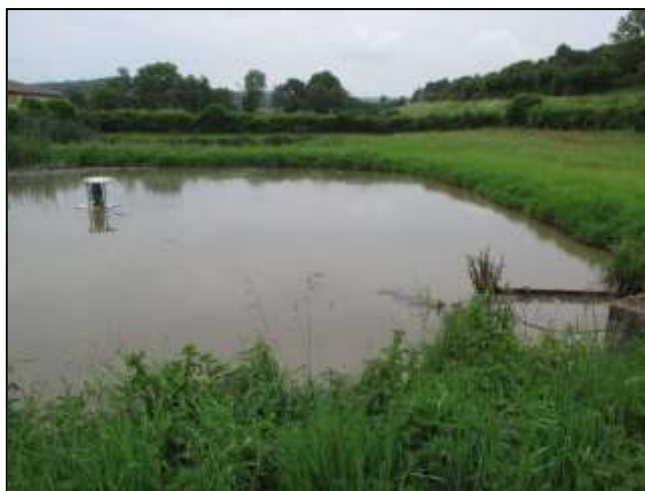
Photographie 5 : Lagunage de Chevagny - "Lotissement" à proximité du Moulin Journet visiblement mal entretenu (taille des bassins réduite, cloison syphoïde hors service, ...)
