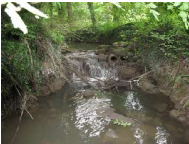
Photographie 30 : exemple d'un seuil pouvant être facilement arasé (seuil sur le ruisseau de Fissy à Lugny)
