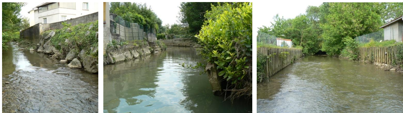
Photographie 5 : Artificialisation des berges en enrochements (gauche), en béton (centre), en bois (droite) :
