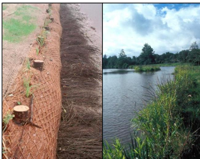
Figure 11: Fascine d'hélophytes avec branches anti-affouillement (Source : BIOTEC)
