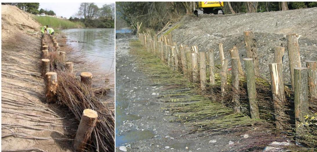
Figure 9: Fascines de saules avec branches anti-affouillement (Source: BIOTEC et P.A Frossard)
