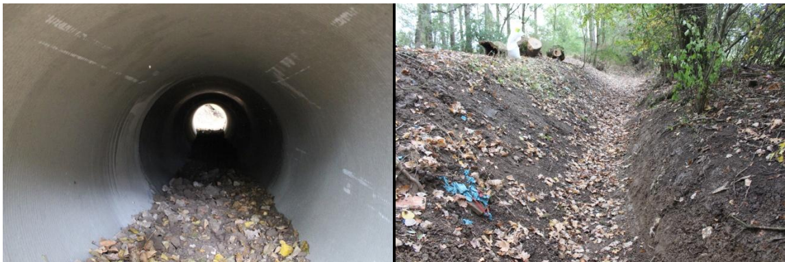
Réaménagement de la buse et du fossé
