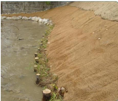
Figure 20: Fascine d'hélophytes (Source: GECO, site internet et ADAM *et al.*, 2008)
