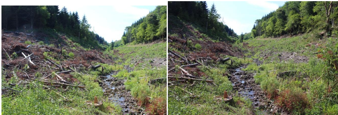
Figure 4: Parcelle avant travaux
