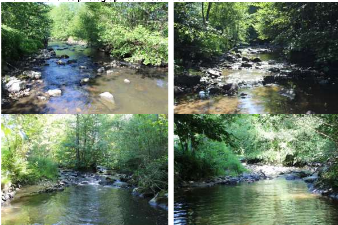
Vues de l'aval du seuil avant (à gauche) et après travaux (à droite)
