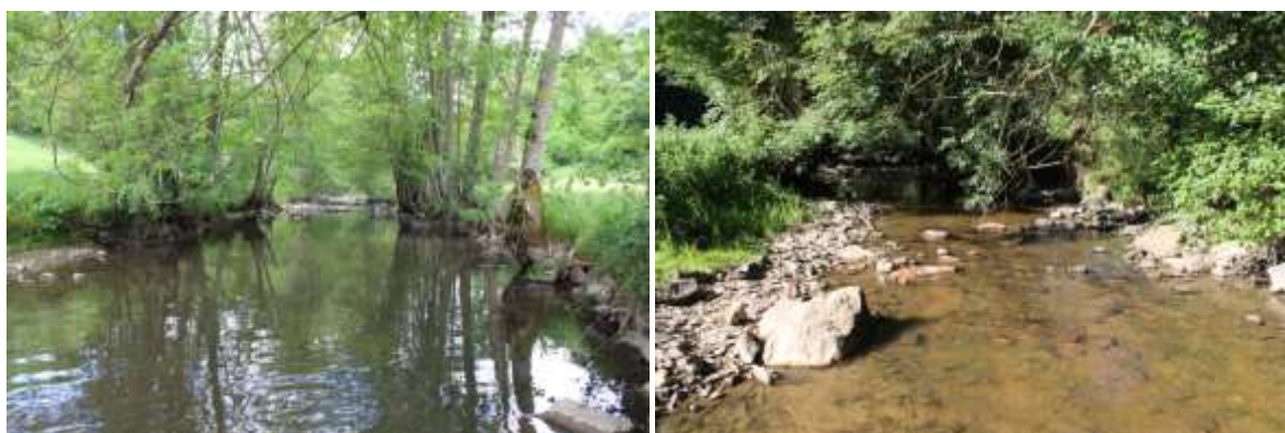
Figure 31 : Vues de l'amont du seuil de Choules avant travaux à gauche (24/05/2014) et après travaux à droite (11/08/2016)
