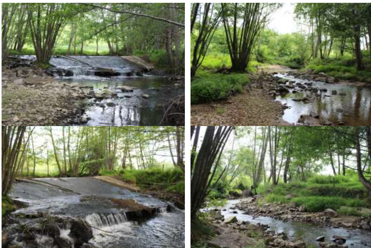
Vues du seuil avant (à gauche) et après travaux (à droite)
