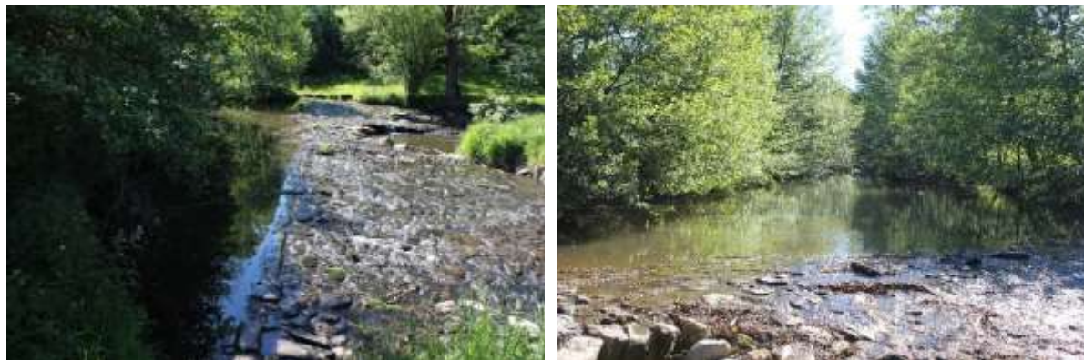
Figure 4: Seuil des Rivières avant travaux (23/05/2014)
