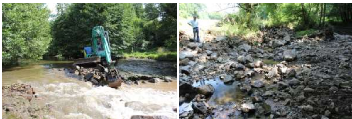
Figure 5: Ouverture d'une brèche sur le seuil des Rivières à gauche (27/08/2014) et suppression complète du seuil de Moulin Fulchiron à droite (8/07/2015)
