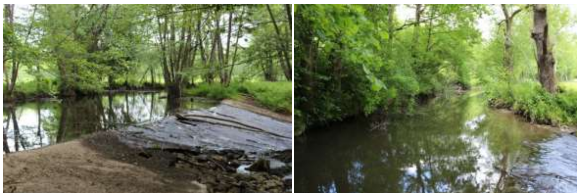
Figure 22: Crêtes des seuils du Rivat à gauche et de Choules à droite (23/05/2014)
