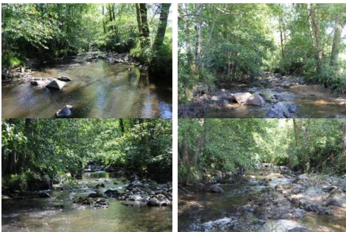
Vues de la limite amont du profil en long avant (à gauche) et après travaux (à droite)
