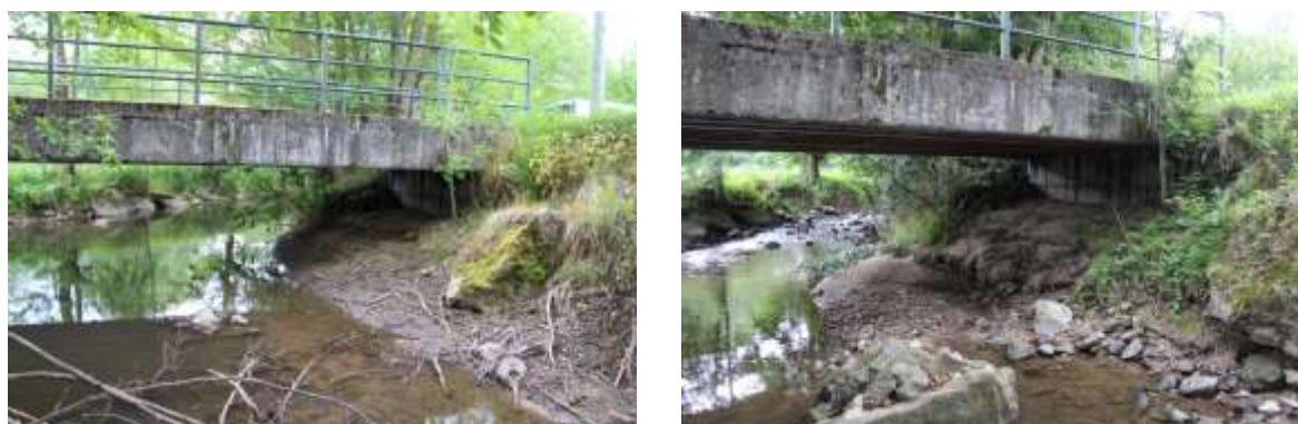
Figure 25: Piles du pont situées dans le remous hydraulique du seuil de Rivat avant travaux (à gauche) et après enfoncement du lit (à droite).
