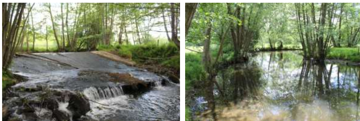
Figure 3 : Seuil de Rivat avant travaux (23/05/2014)
