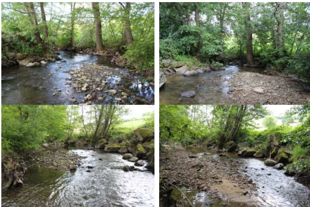
Vues de l'aval du seuil avant (à gauche) et après travaux (à droite)
