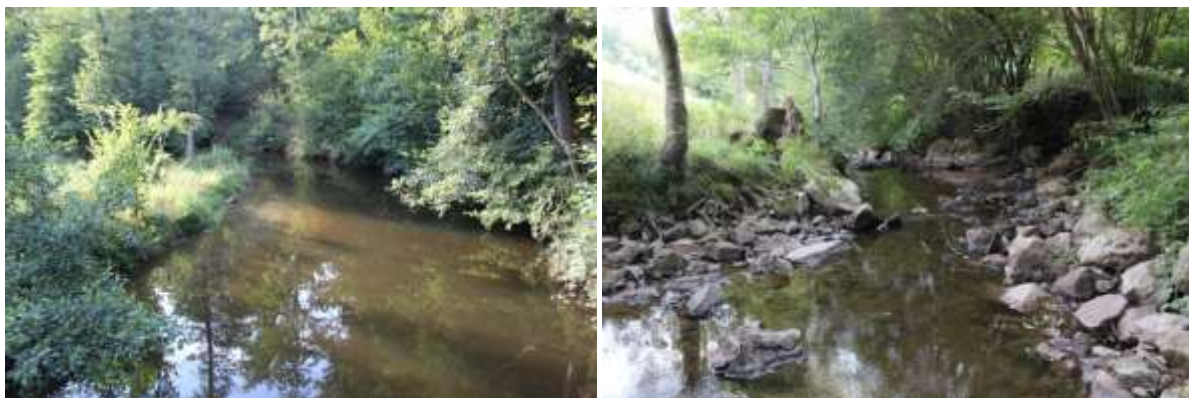
Figure 9: Photographies de l'amont (à gauche) et de l'aval de l'ouvrage (à droite) – 30/07/2015
