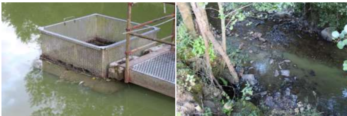
Figure 13: Ouvrage de surverse et rejet dans la Coise (le 30/07/2015)
