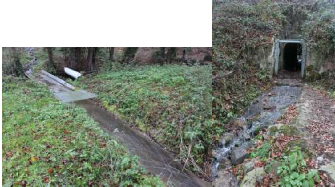
Figure 4: Vues de l'aval de l'affluent
