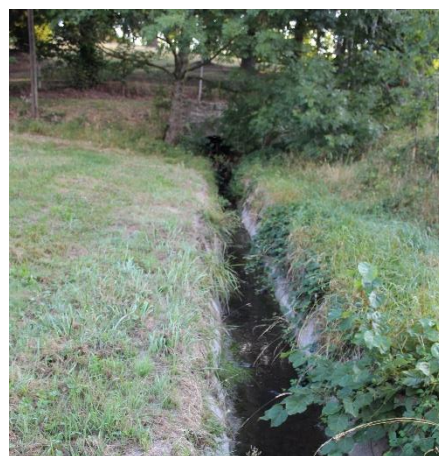
Photographie 3 : Affluent rive droite canalisé dans une cunette béton
