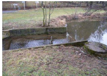
Photographie 2 : Radier haut du seuil
