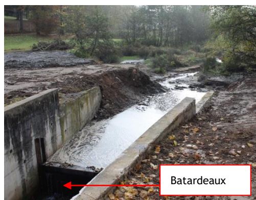
Photographie 4 : Seuil supprimé et mise en place des batardeaux
